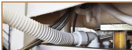
**TUBO SCARICO A PAVIMENTO Ø 40 MM**
